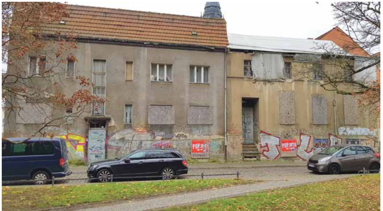
Der Eindruck entsteht, das Bezirksamt hätte sich entschieden, dem Verfall der zwei Gebäude tatenlos zuzusehen.
