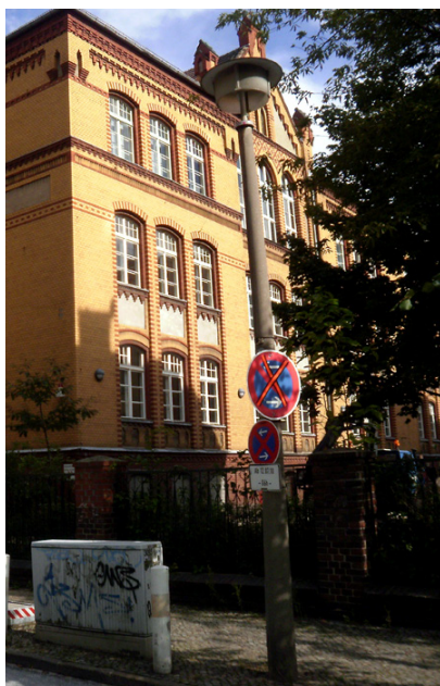
Das Gebäude der Anna-Seghers-Schule platzt aus allen Nähten
