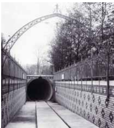
U-Bahn-Probetunnel unter der Spree zwischen der Landgemeinde Treptow und Stralau. Hier Einfahrt in Treptow
