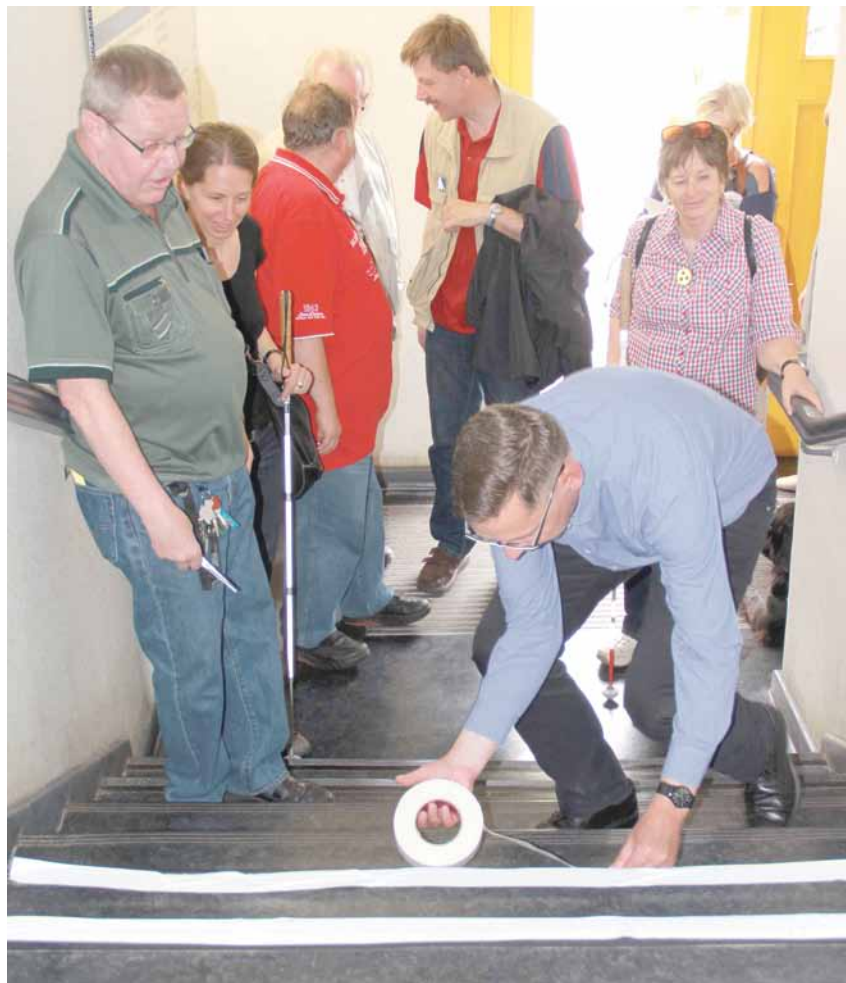
Bezirksstadtrat Gernot Klemm verlegt beim Sozialamt Stufenmarkierungen für Sehbehinderte.
