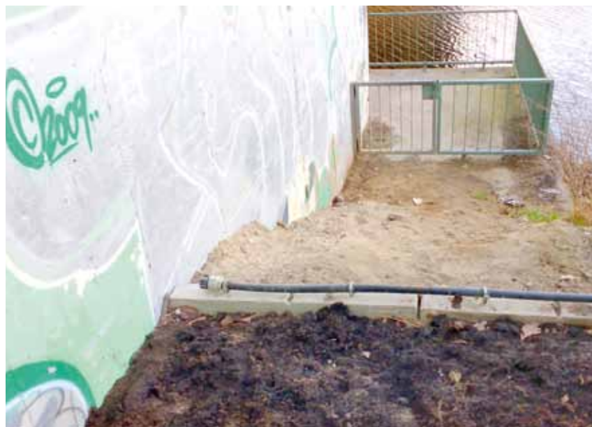
Noch ist der Durchgang an der Wegedornbrücke gesperrt.
