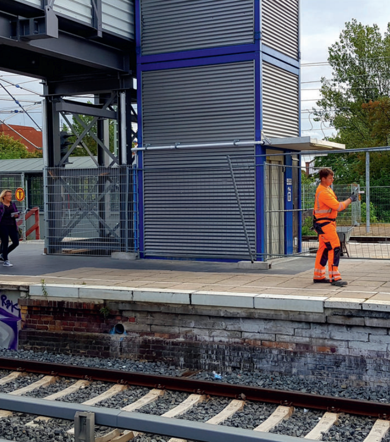
Aufzüge für Barrierefreiheit während der Bauarbeiten am S-Bhf Schöneweide.
