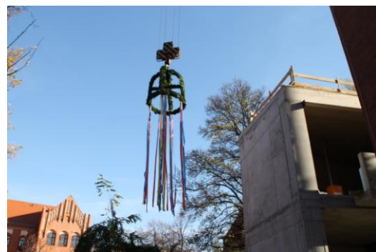
Richtfest zum Bau der Mittelpunktbibliothek
