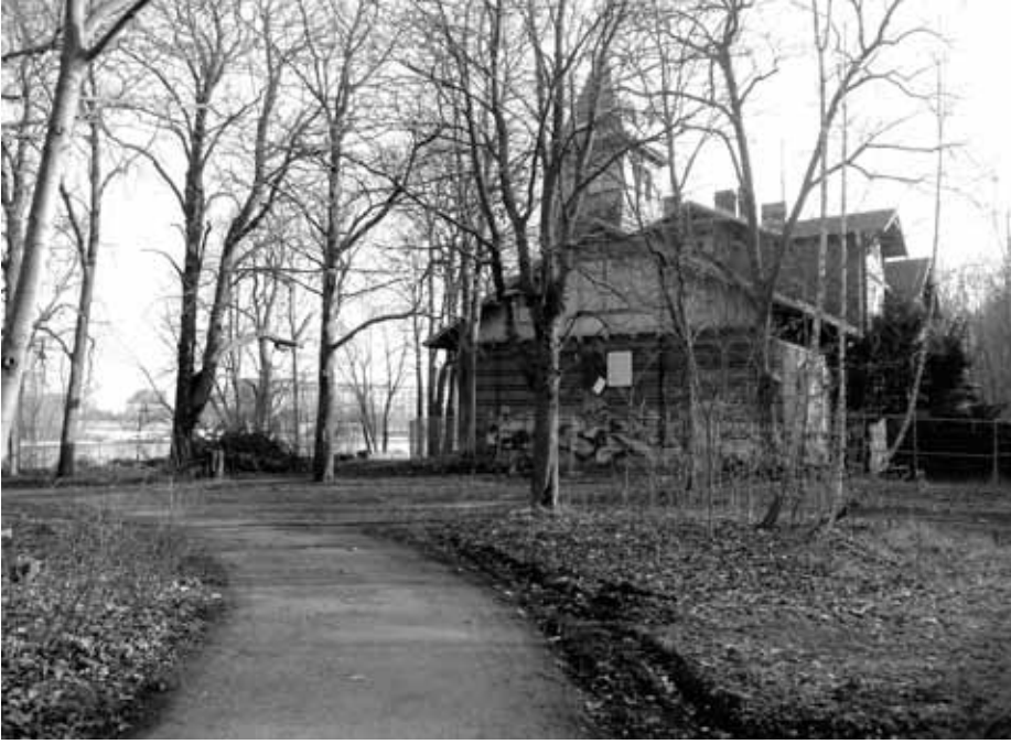
Fuß- und Radwege müssen instandgesetzt werden.
